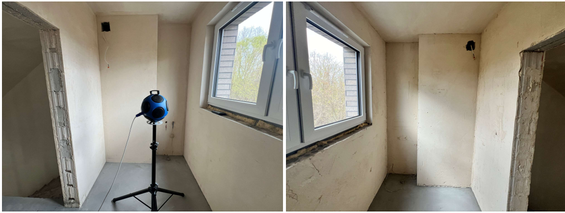
Rys. 4.3 Zdjęcia przegrody nr 2 po stronie pomieszczenia nadawczego i odbiorczego
