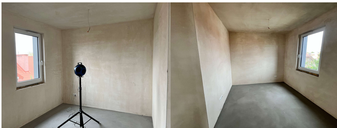
Rys. 4.5 Zdjęcia przegrody nr 3 po stronie pomieszczenia nadawczego i odbiorczego
