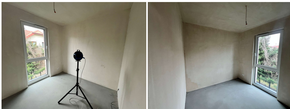
Rys. 4.2 Zdjęcia przegrody nr 1 po stronie pomieszczenia nadawczego i odbiorczego
